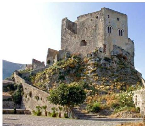
Il complesso si presenta come un blocco compatto costituito da quattro ali che perimetrano una corte interna ove insiste una cisterna. I parametri murari esterni sono contornati da un basamento scarpato motivato dalla necessità di realizzare una efficace difesa alle armi da fuoco. Incassato nel perimetro scarpato si trova il bel portale che, con arcata a tutto sesto e vigorosi conci bugnati, probabilmente è ascrivibile agli interventi cinquecenteschi. *Visitabile in parte e su appuntamento.*
