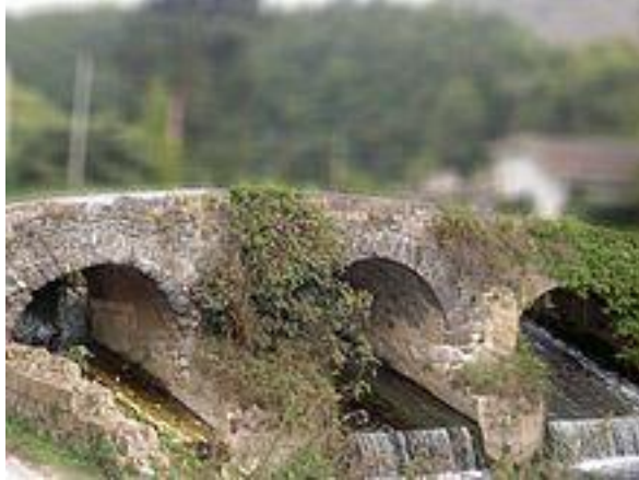
Foto 3 ( Airola ponte sul fiume Isclero)
